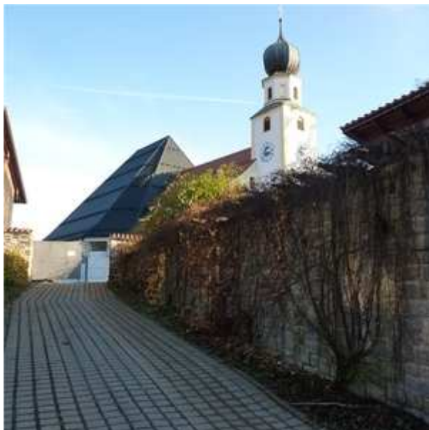
Der Kirchenzugang an der Nordseite des Dorfplatzes ist bei Dunkelheit nur schwach beleuchtet. Foto: kvo
